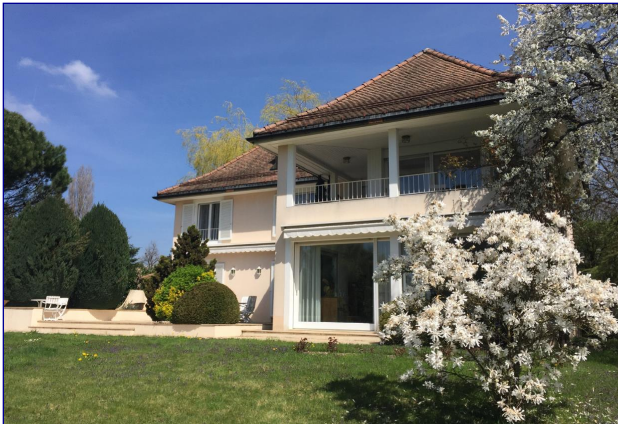
Façade Sud de la maison
